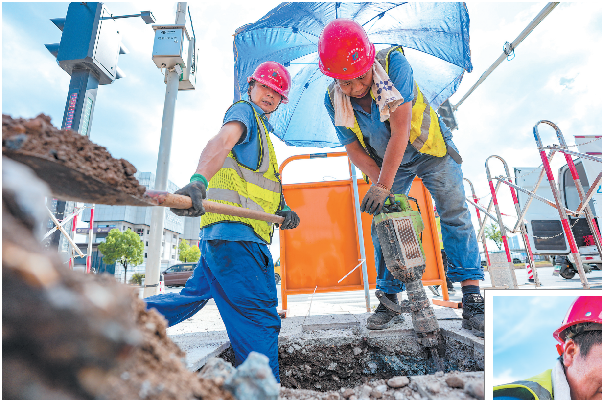
←长沙供水城南抢修中心工作人员在天心大道与新昌路交叉口开挖供水管网漏点,工人李伟辉和王洛“双管齐下”,配合挖开路面。
